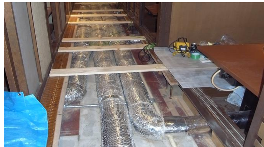
正しい排気ダクトの施工事例
